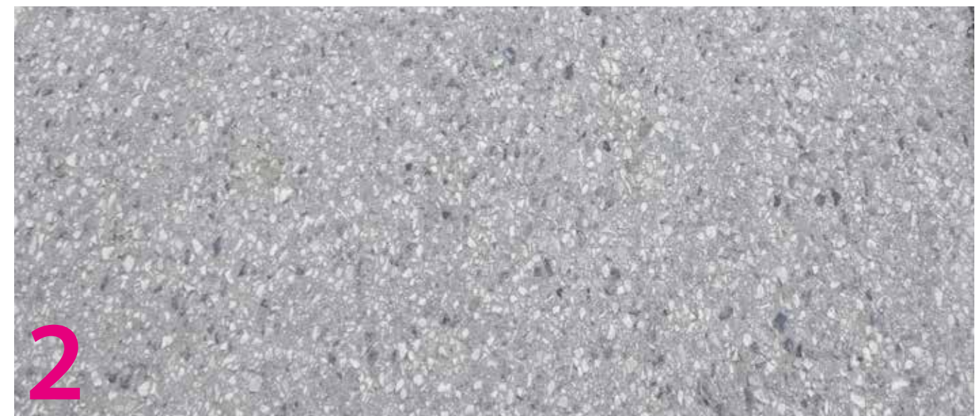
2 Asphaltfläche mit Aufhellungsplitt
